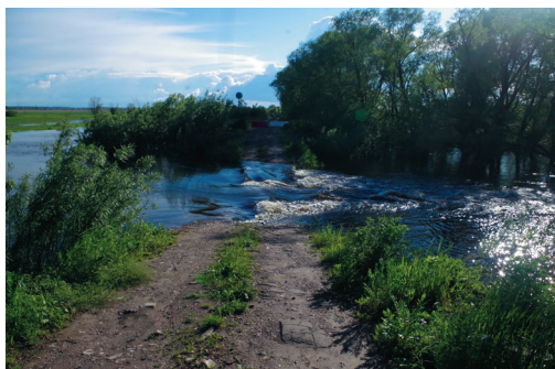
Фото 1. Вода через промочину в дамбе идёт в пойму, 4.06.2020 г.
